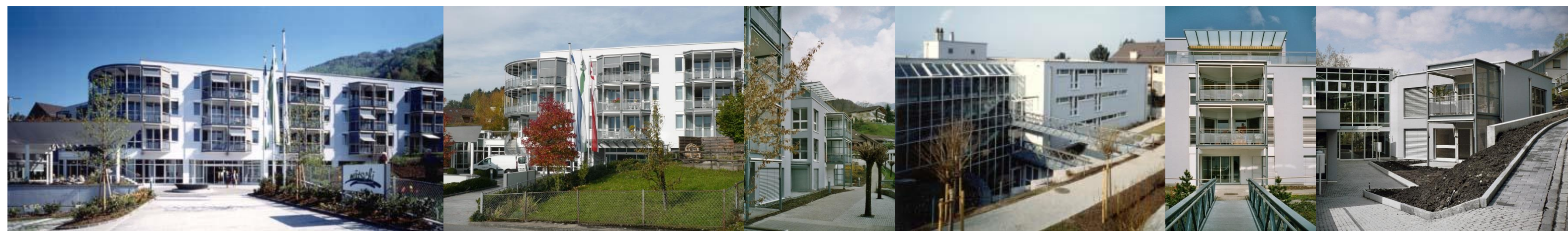
Ansicht Haupteingang und Zimmertrakt Alterswohnheim
